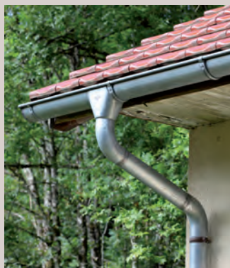
Descentes de gouttières
